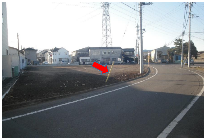
4号地から撮影しました。電柱の支線は出入り の邪魔にならない場所まで移設します。
