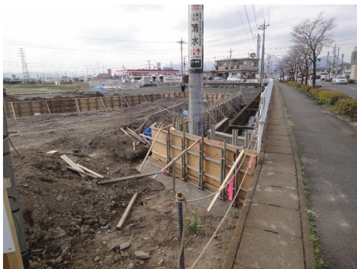
7号地の擁壁の型枠を組んでいます。この後コンクリートを流し込んで擁壁を造ります。
