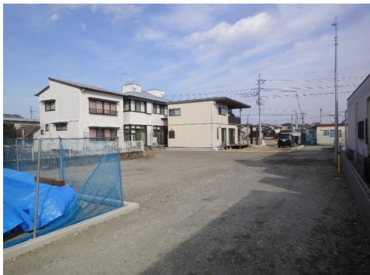
分譲地の西側から撮影 4号地の方の建物が ① 完成しました。
