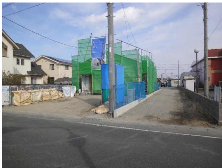
2号地出入口 1号地で建築中の平屋のお家が完成間近か です。
