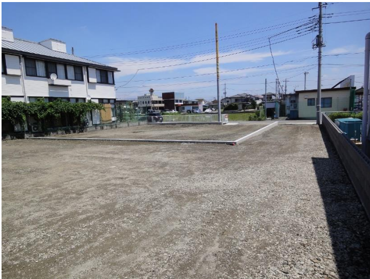
3号地を西側から撮影しました。開発許可後に西側の擁壁を施工します。
