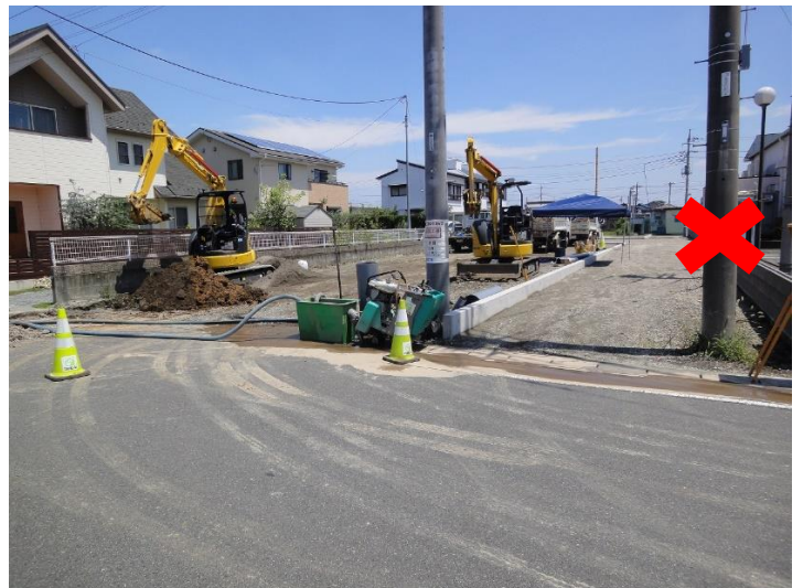
1号地の水道引込工事中です。手前の2号地入口にある電柱も近々撤去となります。
