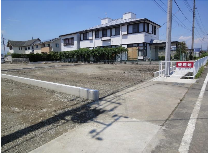
4号地・造成完了しました。隣の区画、3号地の形もイメージ出来ます。
