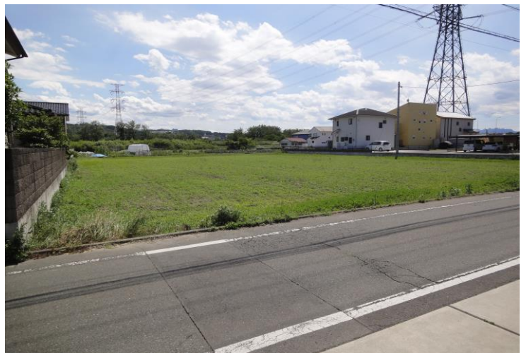
分譲地の西側です。3号地から約70m先に高圧線の鉄塔があります。
