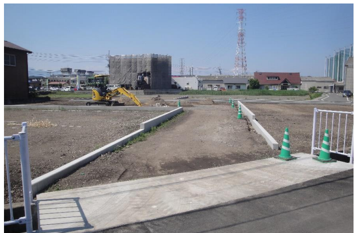
3号地の水路の橋掛けが完成しました。4mの幅があるので、車の出入りも安心です。
