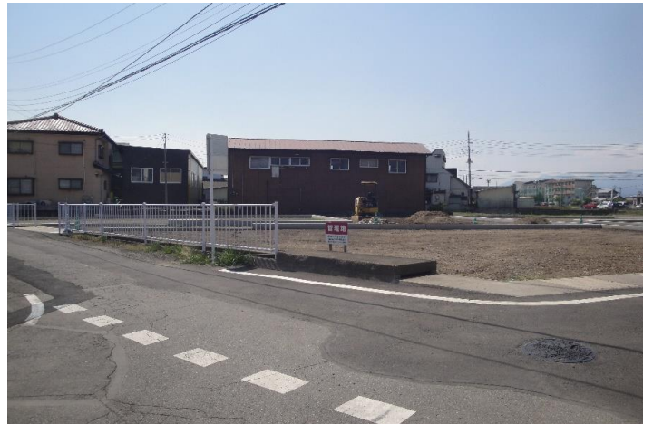
4号地南東から撮影です。造成工事がほぼ完成しました。
