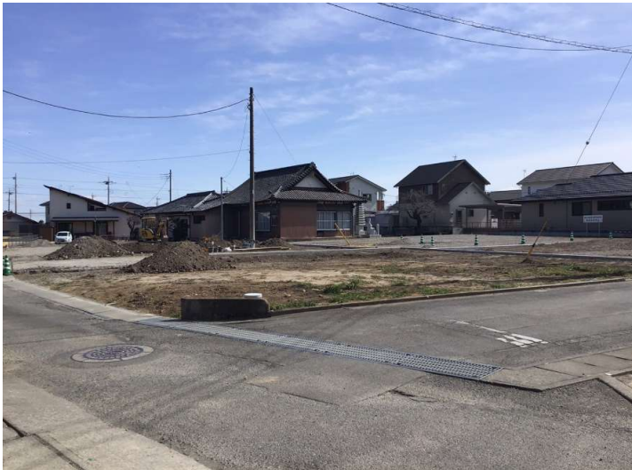
分譲地④号地 北西側より撮影 セットバック要、隅切り擁壁・西側道路と敷地境界の擁壁は高崎市所有の為現況渡しです。
