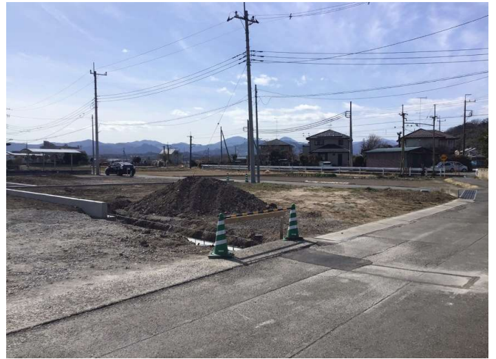
分譲地④号地 北東側より撮影 既存電柱・電線は撤去、南西側に新設予定
