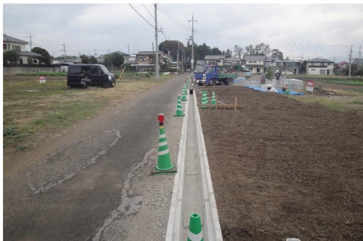
分譲地前面道路です。 道路側溝布設工事が始まりました。
