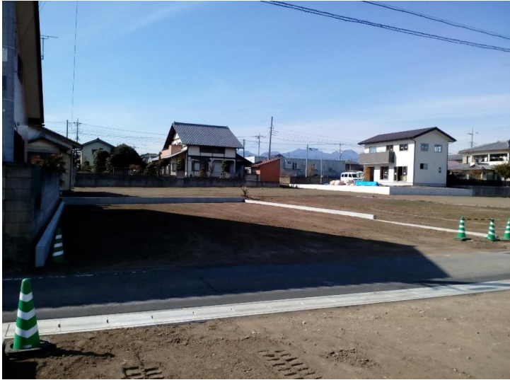
4号地です。 擁壁・整地を行い造成が完了しました。
