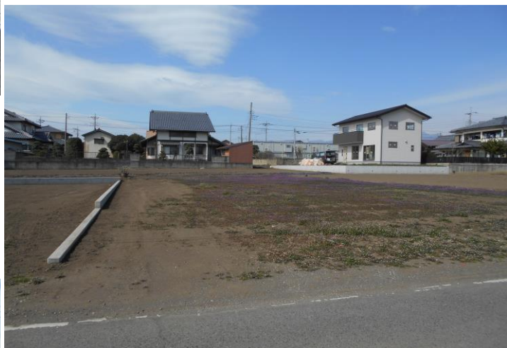
5号地敷延(入口)部分です。 4月には北側の6号地の造成工事が始まります。
