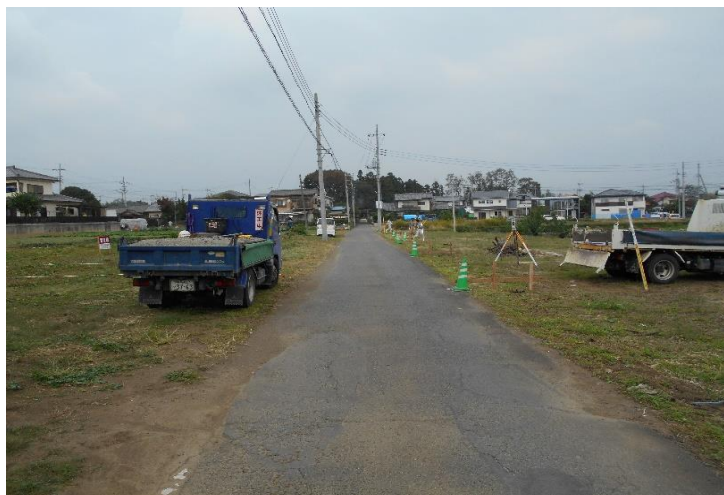
分譲地前面道路です。 セットバック後に4mの市道になります。
