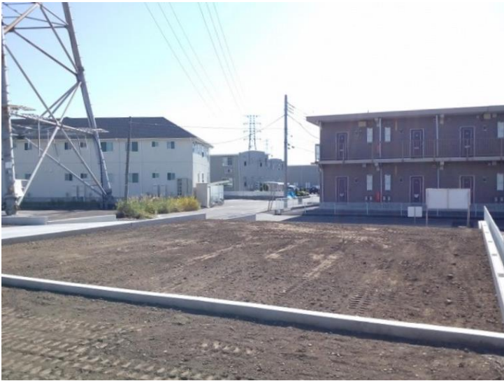
1号地 北西側より撮影しました。 造成工事が完了し、区画が整いました！
