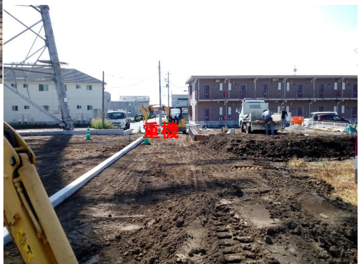
重機が置いてある部分が敷地延長部分になります。 5m幅の土間コンクリート仕上げになります。 地役権で2号地3号地の通路となります。
