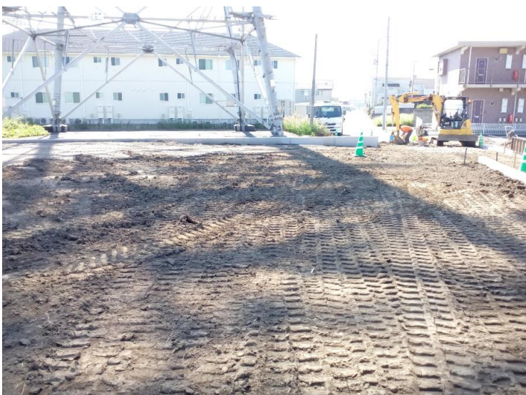
③号地より午前10時30分に南側を撮影しました。 鉄塔の影が写っていますが、現地ではあまり気になりません。日当たりを現地でお確かめください。
