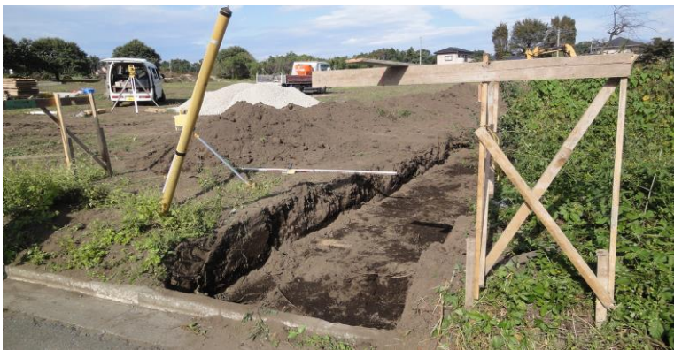
南側擁壁から着工しました
