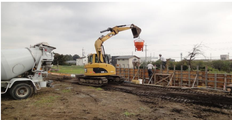
南側擁壁コンクリート打設
