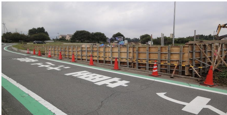
分譲地西側・南側擁壁工事
