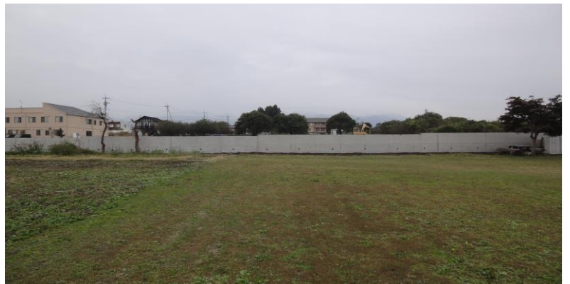
南側擁壁が完成しました
