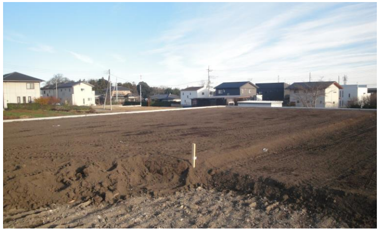
南側の区画 造成が進みました
