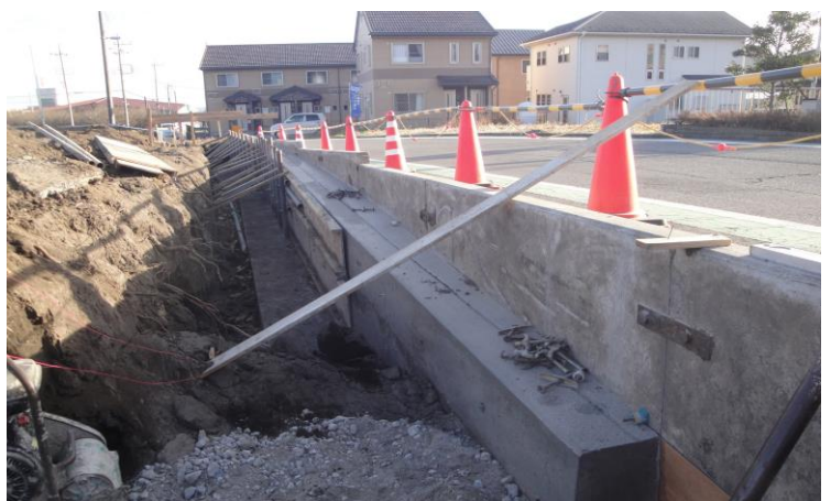
西側道路側 擁壁工事
