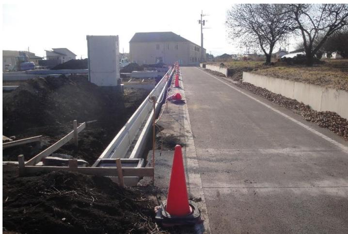
北側道路に側溝設置完了。側溝を含めて幅5mの道路になりました。
