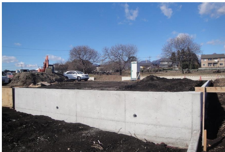
5号地南側擁壁の基礎型枠を外したばかりです。
