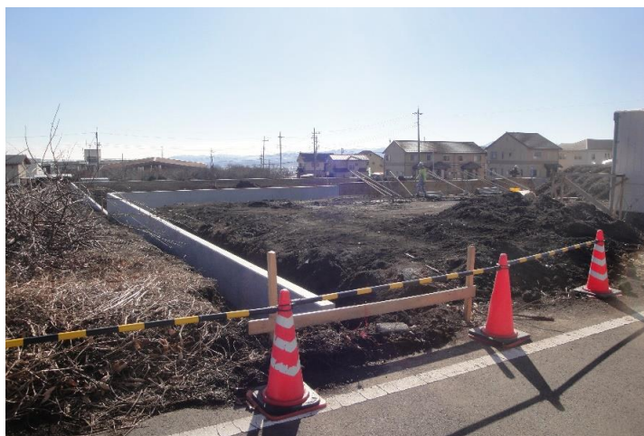
5号地の工事現況です。区画の形が出来上がってきました。
