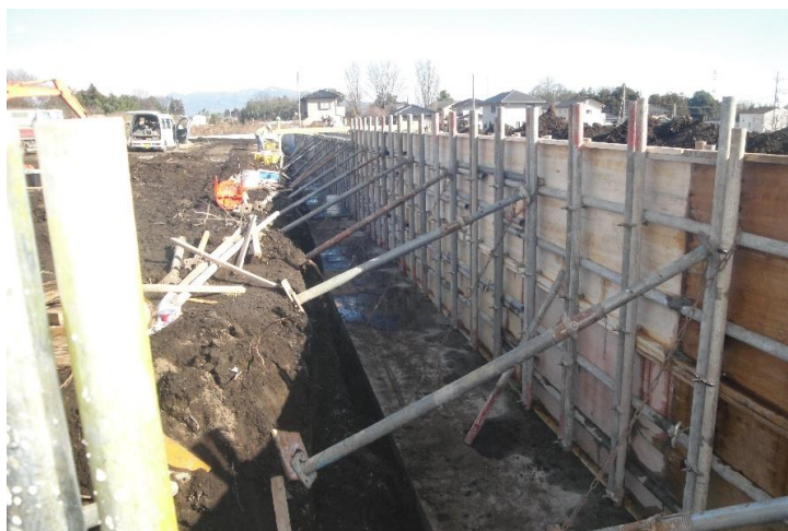
大きな擁壁にはしっかりと支える基礎が入っています。これだけ大きな基礎なら安心です。
