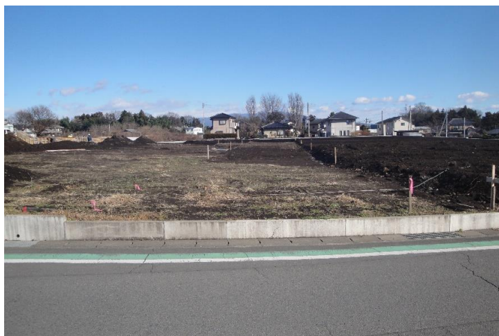
幅6mの開発道路予定地です。
