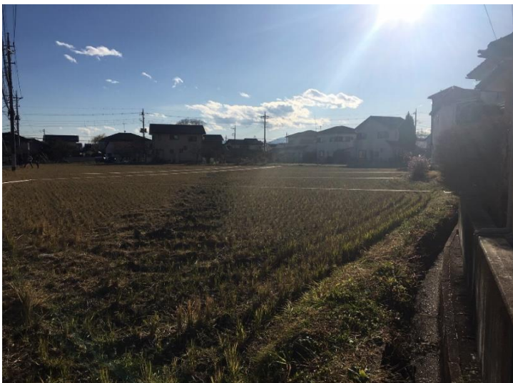
1号地側から撮影しました。 まずは盛土から造成工事を始めます。
