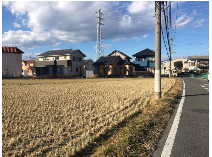
9号地の位置から撮影しました。 1月7日(月)から着工予定です。
