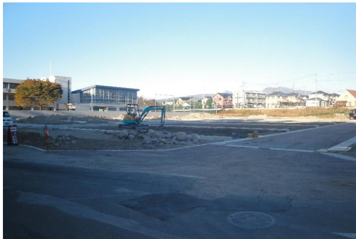
南西角より撮影 大きい石を撤去して敷地を整地しています。
