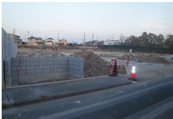
ゴミ集積場のブロック工事が終わりました。土間コンクリートで仕上げます。
