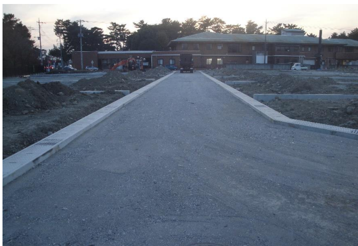
開発道路の路盤工事中です。碎石を20cm敷いてあります。
