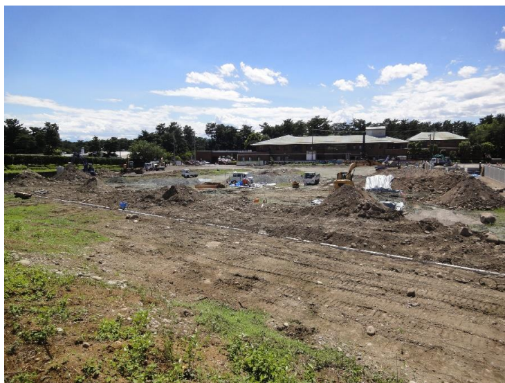
分譲地東側の擁壁が完成しました。東側は水路用地との高低差はありません。
