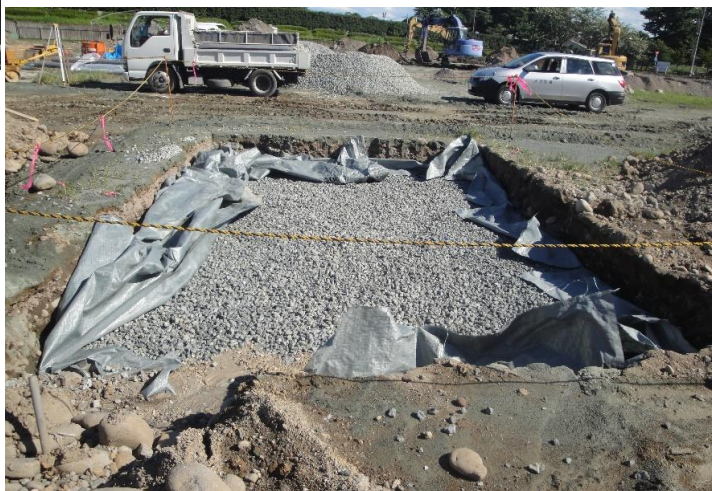
3号地：雨水浸透槽に砕石が入りました。この上に土を約50cm被せて完成です。
