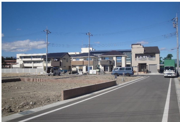
⑳号地東側より撮影です。 これから真ん中の区画も建築が始まり家が建ち 並び始めます。
