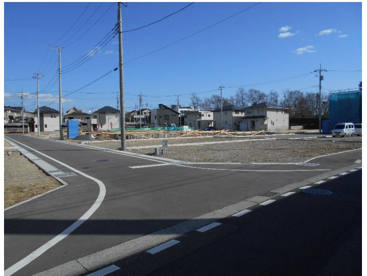
1号地から撮影しました。 分譲地の北道路の区画も基礎工事が始まりました。
