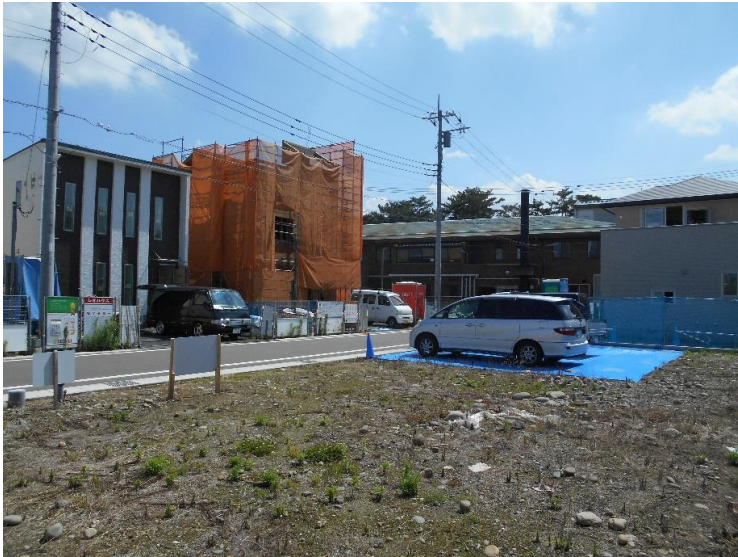
2号地から南側を撮影しました。 北道路の区画の建築が進んでいます。
