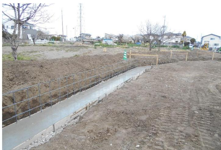
2号地北側の境界擁壁の立ち上がり部分の鉄筋が見えています。
