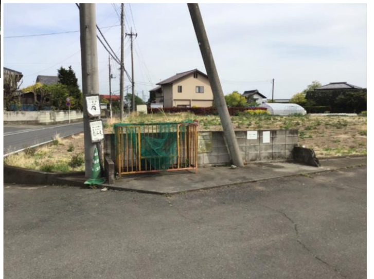
分譲地 北西側より撮影 1号地に隣接のゴミ集積場は補修を行ない、ゴミ集積庫を設置予定です。
